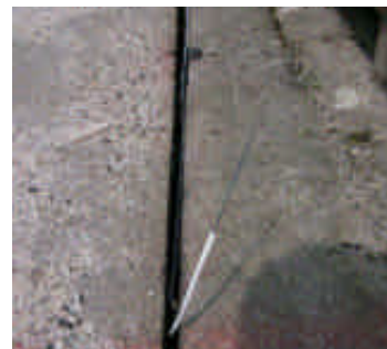
Figure 9.23 : Réalisation de micro-rainurage sur chaussée ou trottoir
